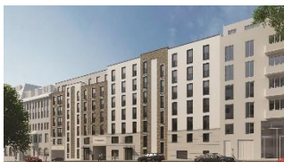
BA 1 Ansicht von Saarbrückerstraße
