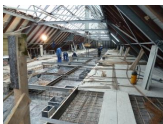
Hafthaus IV Herstellung Trägerrost für Betonglasdecken
