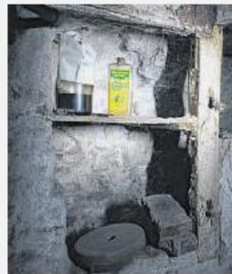
Die Kellerwände gehören zum Teil zur einstigen Stadtmauer.
