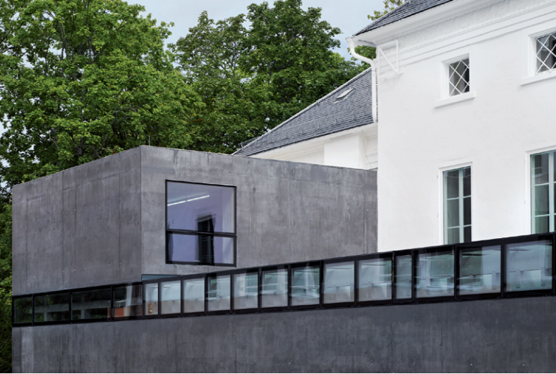
Der moderne Anbau betont kontrastierend den historischen Bestand des Museums Biedermann in Donaueschingen – gäbele & raufer Architekten BDA, Donaueschingen – Foto: Bernhard Strauss
