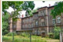
„Eiswerder Str. 13 GbR“, Berlin-Spandau
