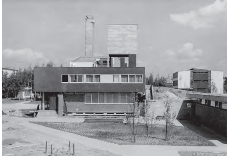
Abb. 8: Gemeinschaftshaus Studentendorf Schlachtensee kurz vor der Fertigstellung 1964
