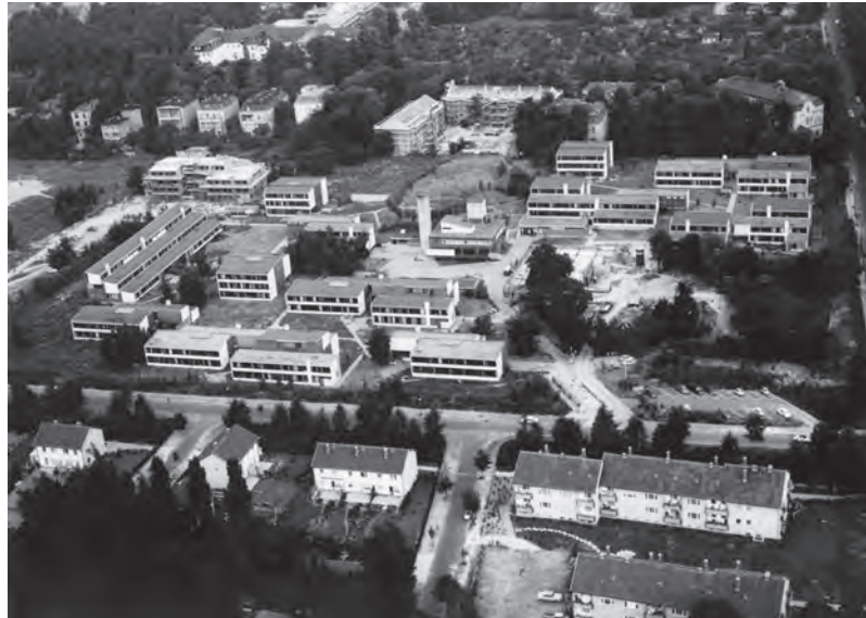
Abb. 4: Luftaufnahme des Wohncampus ca. 1963
