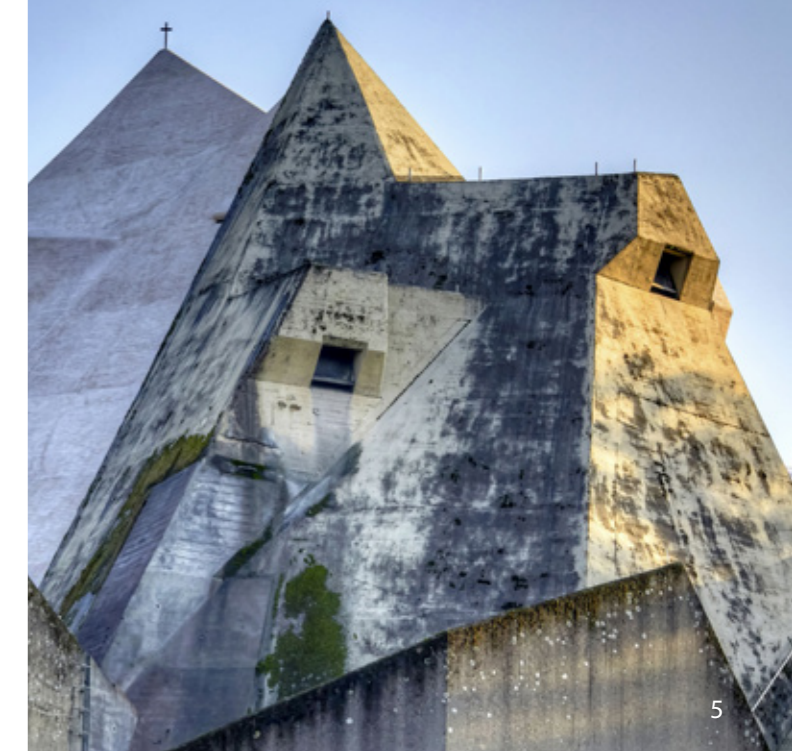
Der Mariendom in Neviges, dessen Betonsanierung die Deutsche Stiftung Denkmalschutz gefördert hat
