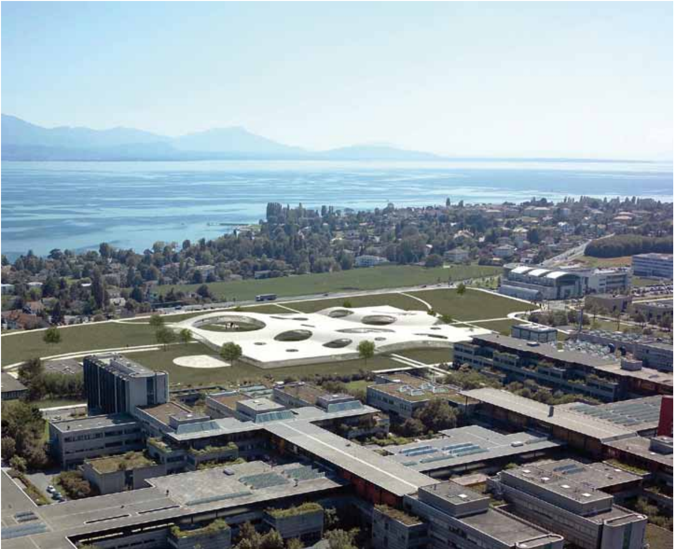
10 Rolex Learning Center Lausanne, SANAA, Tokyo mit Bollinger + Grohmann Ingenieure, Frankfurt am Main
