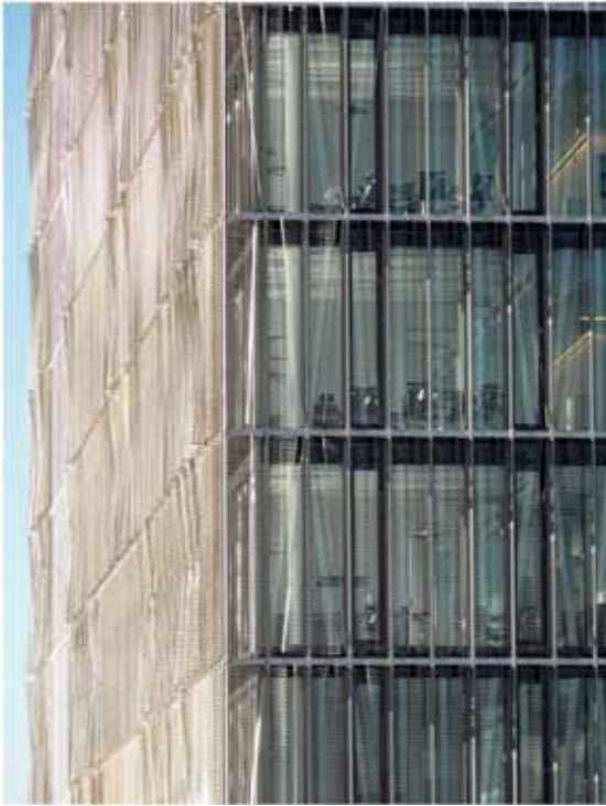
18 Sonnenschutzsystem am Q1 Gebäude
