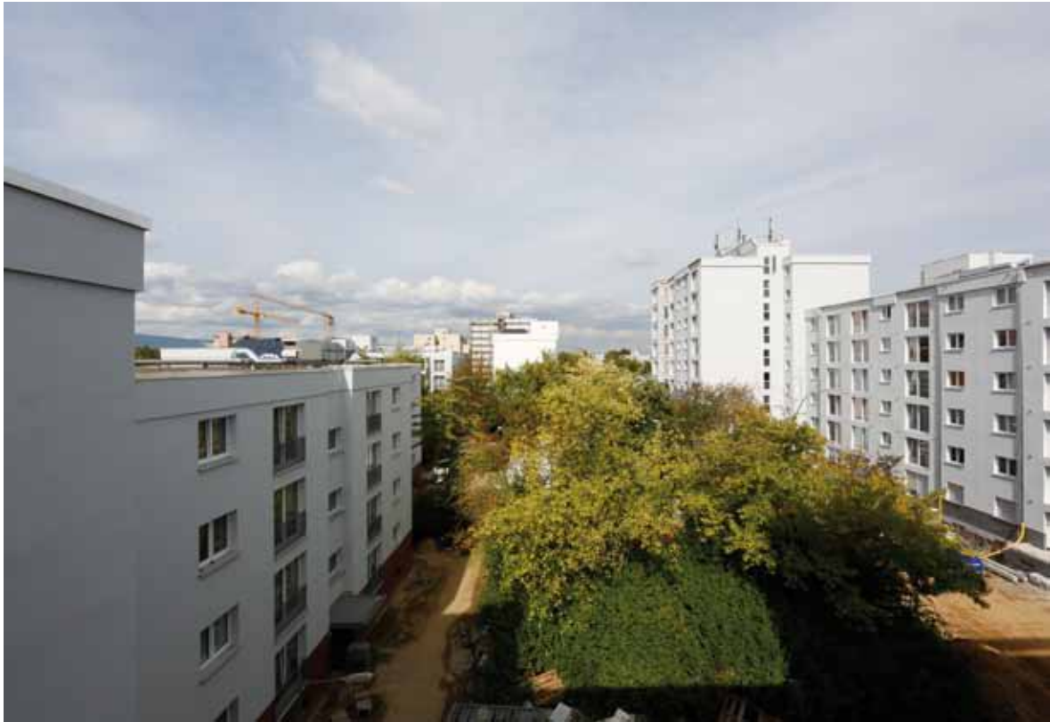
32 ARCHITEKTONISCH-ENERGETISCHE SANIERUNG DER HEINRICH-LÜBKE-SIEDLUNG Fassaden nach den Sanierungsmaßnahmen
