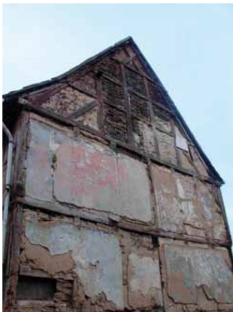
19 Fassade vor den Sanierung
