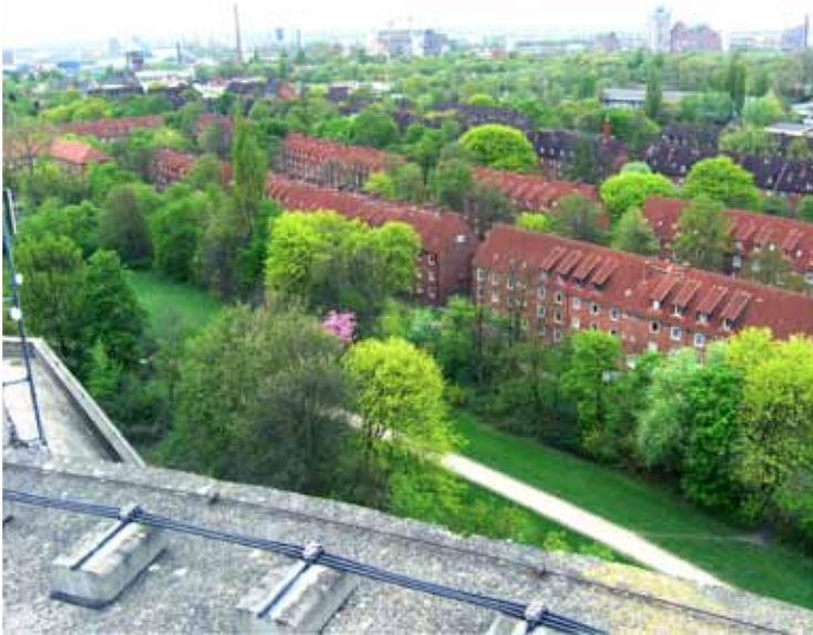
42 Das Weltquartier vor der Sanierung
