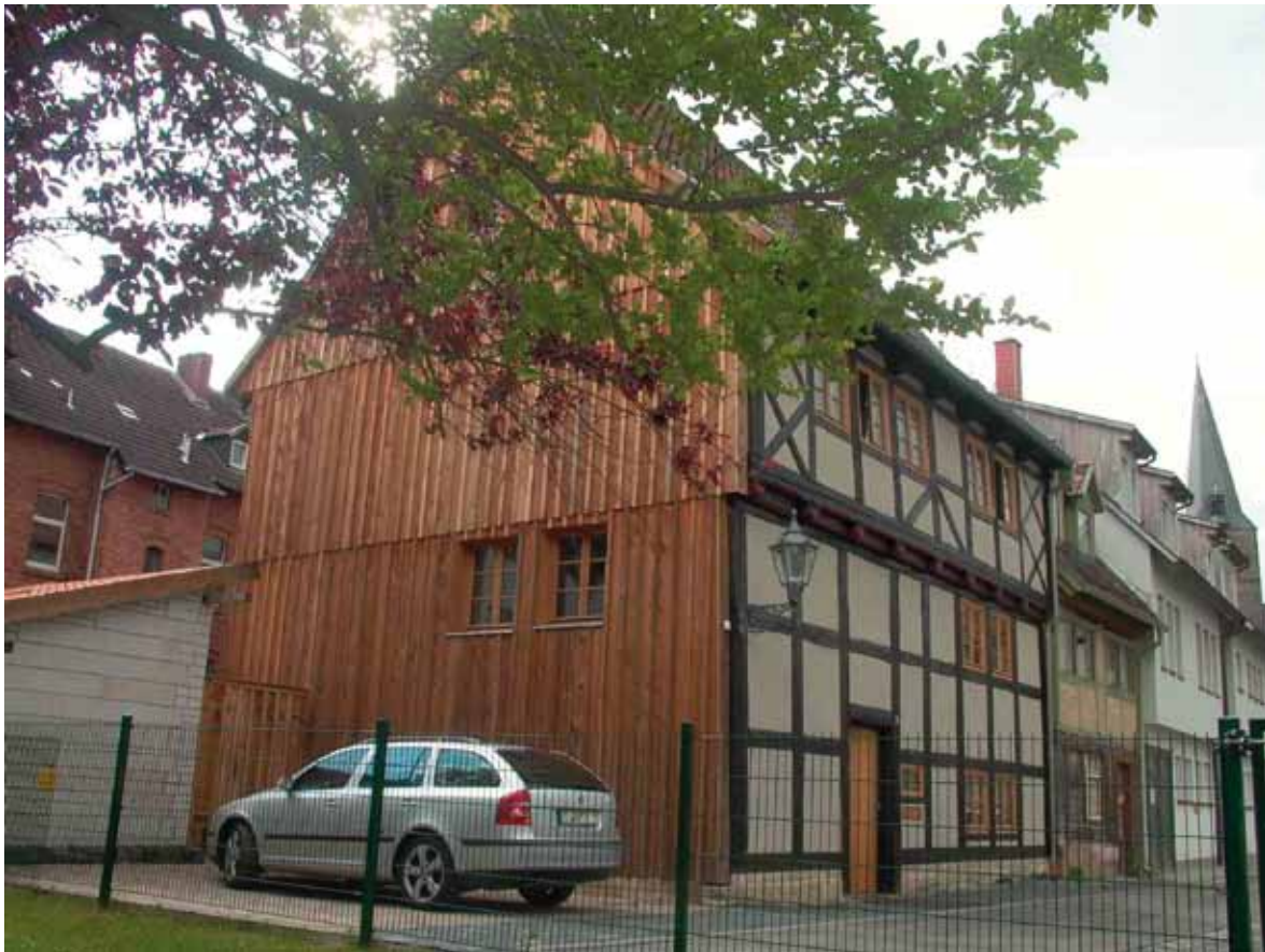
18 ENERGETISCHE SANIERUNGSMASSNAHMEN IM WELTKULTURERBE QUEDLINBURG Dämmen am Denkmal – im Einzelfall möglich
