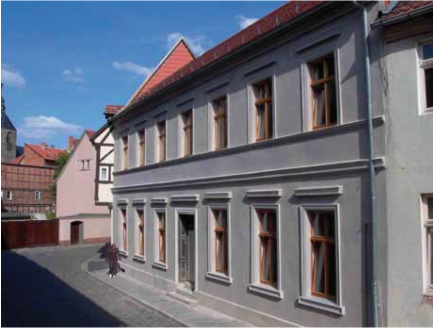
20 Sanierungsbeispiel Hohe Straße 4
