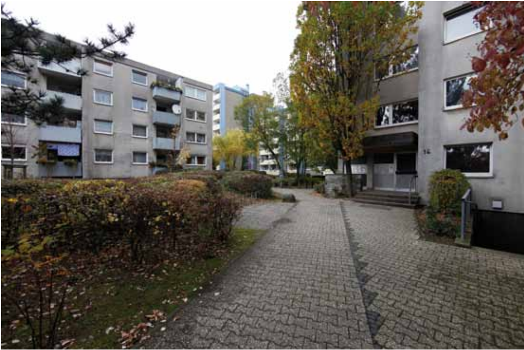
35 Hofsituation vor den Sanierungsmaßnahmen
