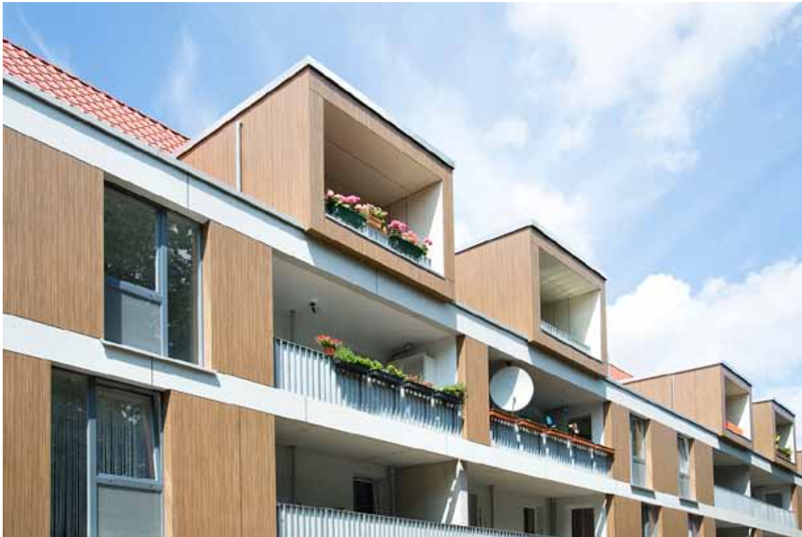
39 IBA-WELTQUARTIER HAMBURG Sanierte Wohnungen im Bestand
